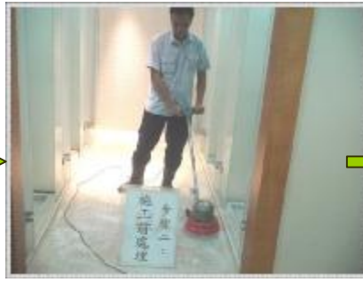
步驟二：施工前處理
